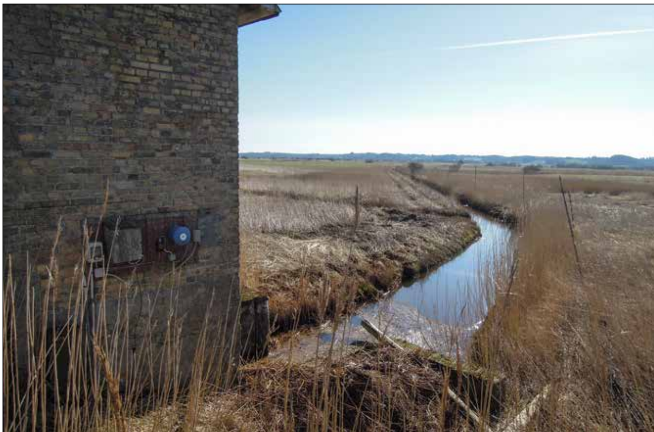
Pumpen stoppes og de lavtliggende områder bag pumpehuset oversvømmes.
